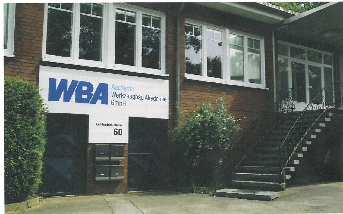
Die neu eröffnete Werkzeugbau Akademie residiert in einer umgenutzten Industriehalle, bis sie auf den neuen RWTH-Aachen-Campus ziehen wird
